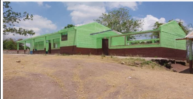
Foto 1: Cambio de cubierta de lamina.
