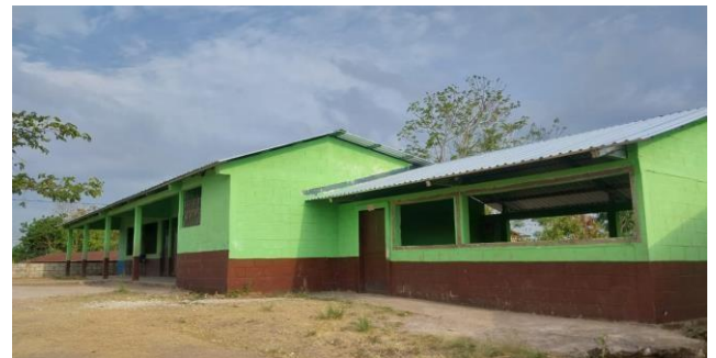
Foto 2: Instalacion de cubierta de lamina troquelada.
