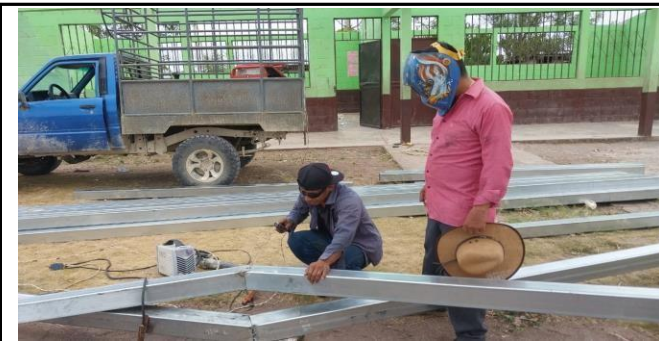
Foto 3: Instalacion de estructura de metal de los modulos priorizados.
