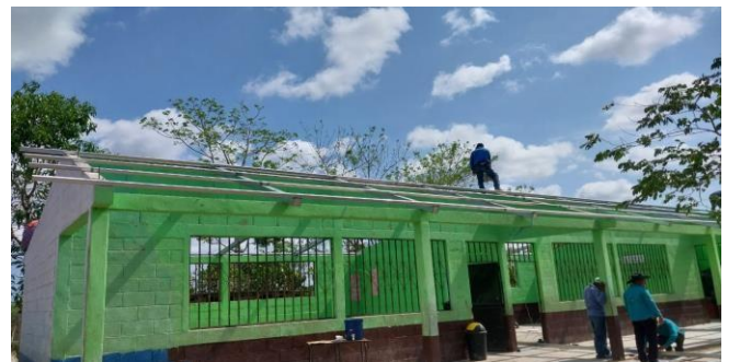
Foto 4: Instalacion de estructura de portante de metal.
